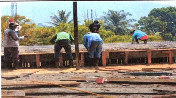
3. REPARACIÓN DE PLANCHA CONCRETO DE PATIO.
