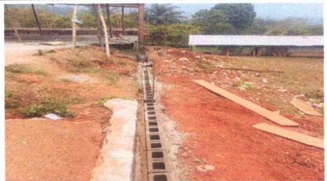
4. LEVANTAMIENTO DE BASES DEL TARIMA.
