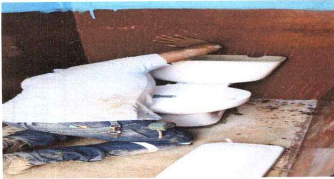
1. SUSTITUCIÓN DE INODORO.
