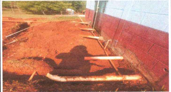
2. REPARACIÓN RED DE DRENAJE.
