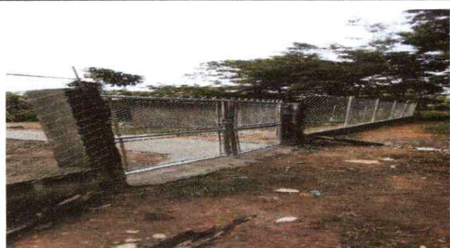
FOTO 3: SE OBSERVA LA FINALIZACIÓN DEL MANTENIMIENTO DE PORTON DE METAL
