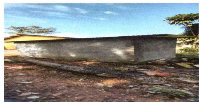
FOTO 5: SE OBSERVA LA FINALIZACIÓN DEL REPELLO EN MURO
