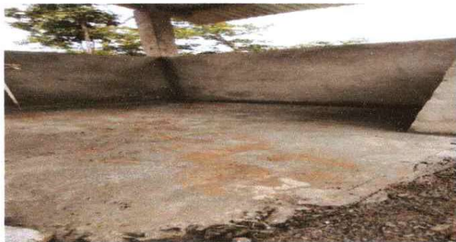
FOTO 1: SE OBSERVA LA FINALIZACIÓN DE LA SUSTITUCIÓN DE PISO DE TORTA DE CONCRETO
