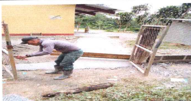
FOTO 3: PROCESO DE MANTENIMIENTO A PORTON DE METAL
