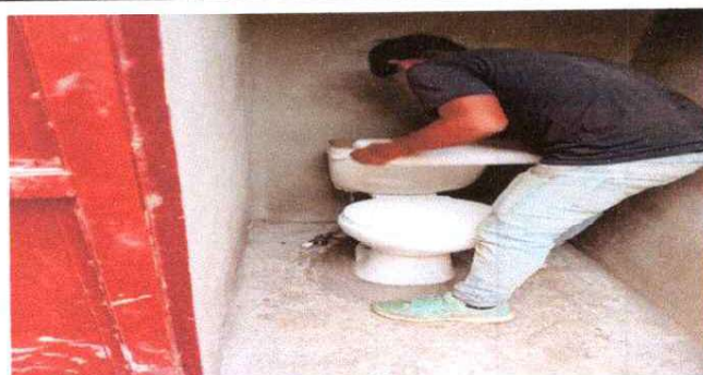
FOTO 2: PROCESO DE SUSTITUCION DE INODORO
