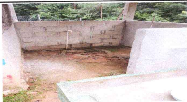
FOTO 1: PROCESO DE SUSTITUCIÓN DE PISO DE TORTA DE CONCRETO
