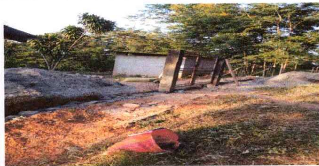
FOTO 4: PROCESO DE REPARACIÓN DE MURO PERIMETRAL
