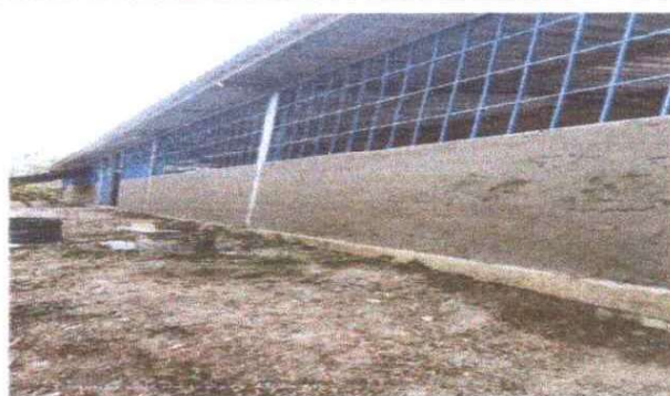
FOTO 4: Sustitución de ventana de madera por metal
