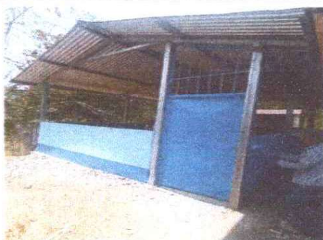
FOTO 3: Sustitución de puerta de madera por metal
