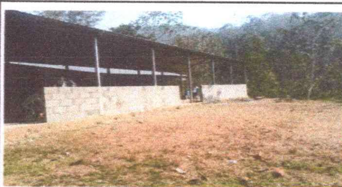
FOTO 2: Sustitución de pared de madera por pared de block
