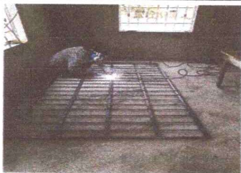
FOTO 5: Sustitución de ventana de madera por metal
