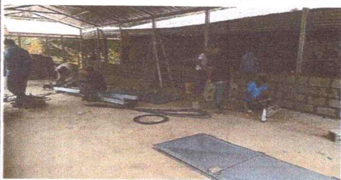
FOTO 3: Sustitución de puerta de madera por metal
