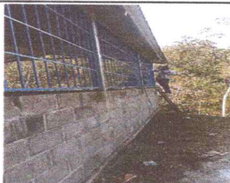
FOTO 4: Sustitución de ventana de madera por metal
