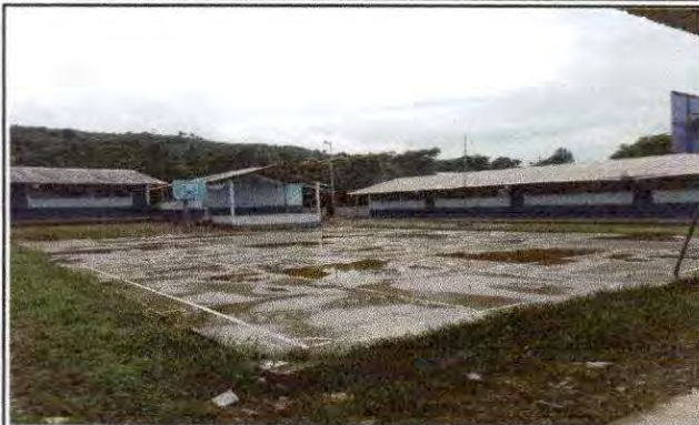
Foto 2: REMOZAMIENTO DE AULAS
