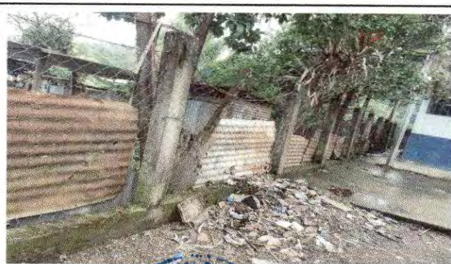
Foto 11: AMPLIACION MURO EN AULA CON REFUERZO ESTRUCTURAL
