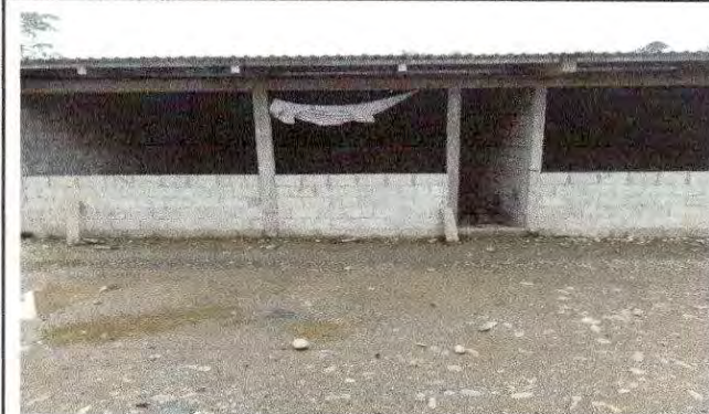
Foto 4: REMOZAMIENTO DE AULA
