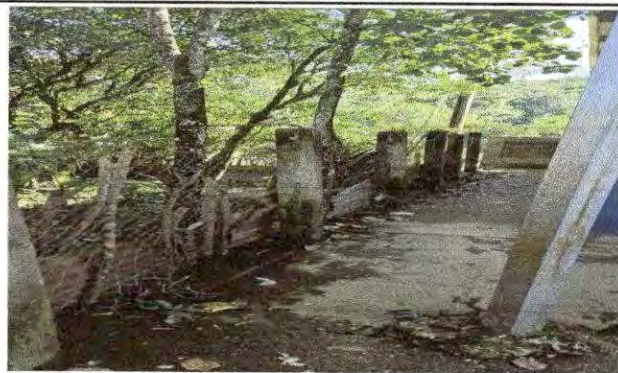
Foto 9: MURO PERIMETRAL CON REFUERZO ESTRUCTURAL-
