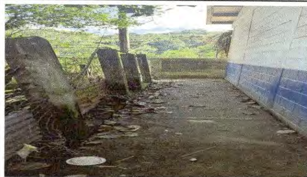
Foto 10: AMPLIACION MURO EN AULA CON REFUERZO ESTRUCTURAL
