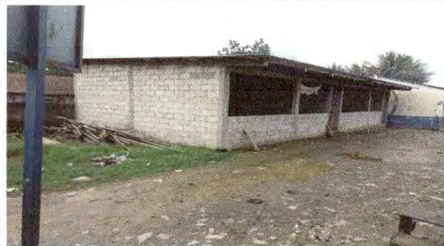
Foto 3: REMOZAMIENTO DE AULAS
