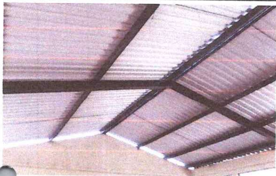
FOTO 1: SUSTITUCION DE LAMINA TROQUEALDA CAL.26
