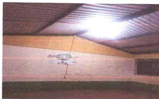
FOTO 6: REPARACION DE SISTEMA ELECTRICO
