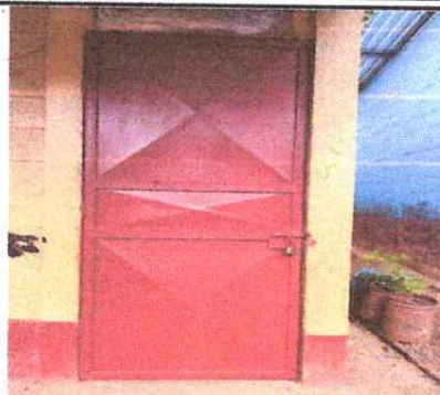
FOTO 2: INSTALACION DE PUERTA DE METAL
