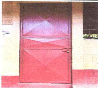
FOTO 1: INSTALACION DE PUERTA DE METAL
