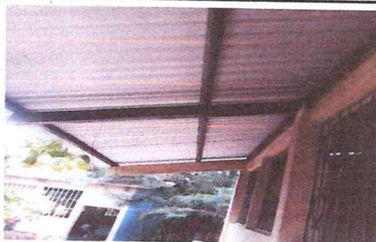
FOTO 2: SUSTITUCION DE LAMINA TROQUEALDA CAL.26
