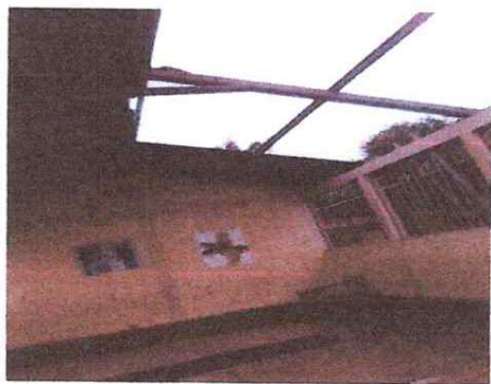
FOTO 1: SUSTITUCION DE LAMINA POR LAMINA TROQUEALDA
