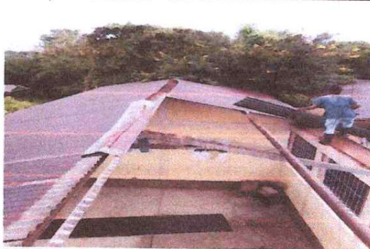
FOTO 2: SUSTITUCION DE LAMINA POR LAMINA TROQUELADA
