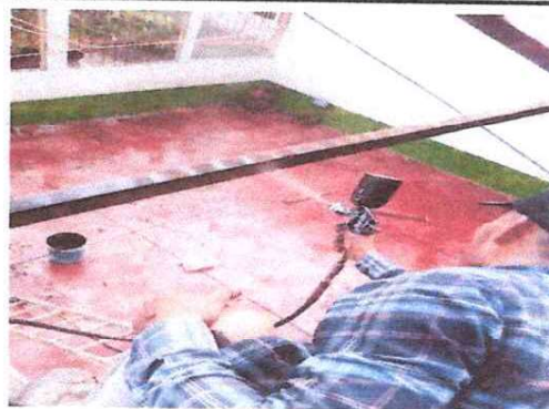
FOTO 4: MANTENIMIENTO A ESTRUCTURA DE METAL
