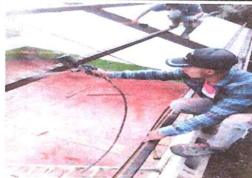
FOTO 5: MANTENIMIENTO A ESTRUCTURA DE METAL
