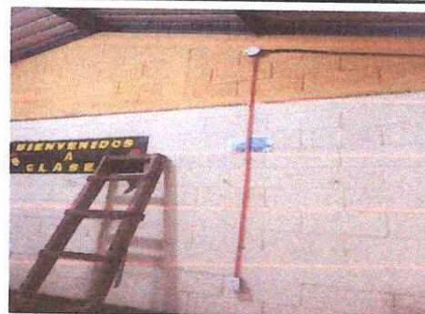
FOTO 6: REPARACION DE SISTEMA ELECTRICO
