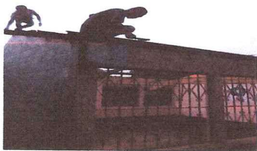
FOTO 3: MANTENIMIENTO A ESTRUCTURA DE METAL
