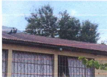
FOTO 2: SUSTITUCION DE LAMINA POR LAMINA TROQUELADA
