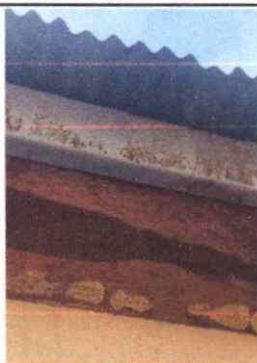
FOTO 3: MANTENIMIENTO A ESTRUCTURA DE METAL
