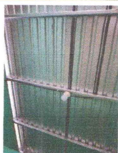
Foto 5: SUSTITUCIÓN DE DUCTO ELÉCTRICO + ACCESORIOS
