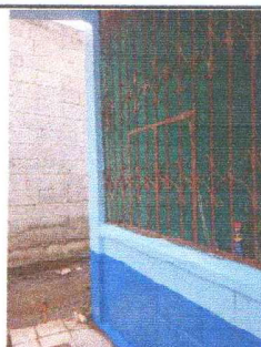
Foto 6: PINTURA EN MURO EXTERIO E INTERIORES
