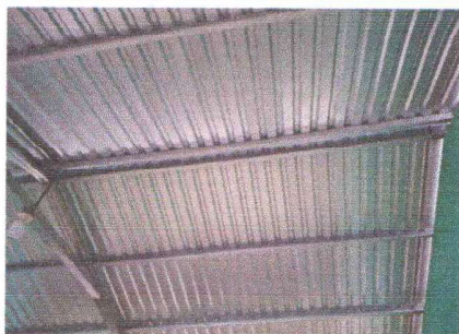
Foto 1: SUSTITUCIÓN DE LÁMINAS POR LÁMINAS TROQUELADA ALUZINC CALIBRE 26
