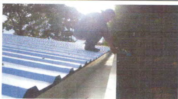
Foto 3: SUSTITUCIÓN DE CANAL DE PVC
