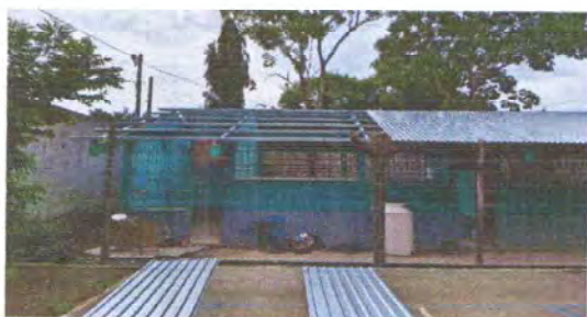
Foto 1: SUSTITUCIÓN DE LÁMINAS POR LÁMINAS TROQUELADA ALUZINC CALIBRE 26
