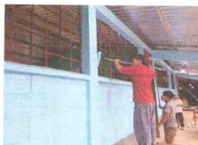
Foto 6: PINTURA EN MURO EXTERIO E INTERIORES
