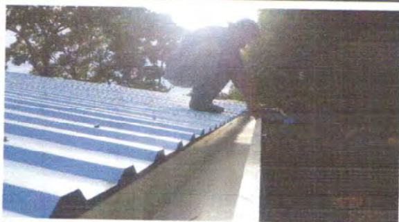
Foto 3: SUSTITUCIÓN DE CANAL DE PVC
