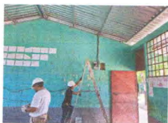
Foto 5: SUSTITUCIÓN DE DUCTO ELÉCTRICO + ACCESORIOS
