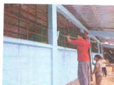
Foto 6: PINTURA EN MURO EXTERIO E INTERIORES
