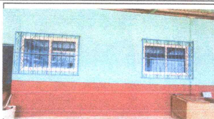
FOTO 2: FABRICACIÓN E INSTALACIÓN DE BALCONES Y VENTANAS DE VIDRIO.
