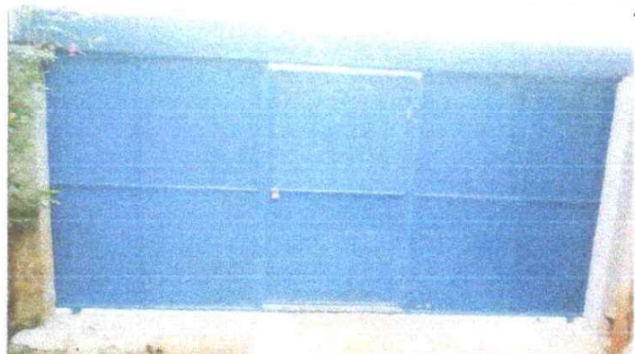
FOTO 4: FABRICACION E INSTALACION DEL PORTON CORREDIZO.
