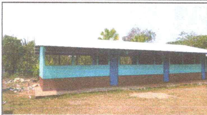
FOTO 1: INSTALACIÓN DE LAMINAS TROQUELADAS
