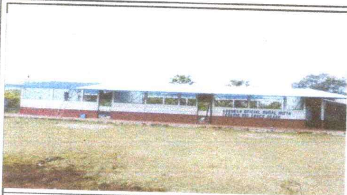
FOTO 1: DESARROLLO DE LA INSTALACIÓN DE LAS LAMINAS TROQUELADAS.
