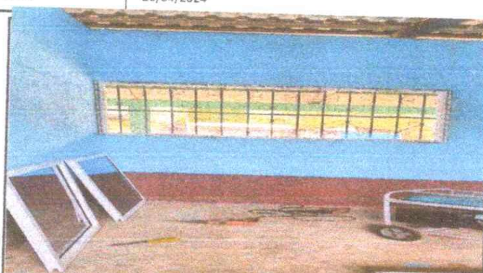
FOTO 2: DESARROLLO DE LA FABRICACION DE LOS BALCONES Y VENTANAS DE VIDRIO
