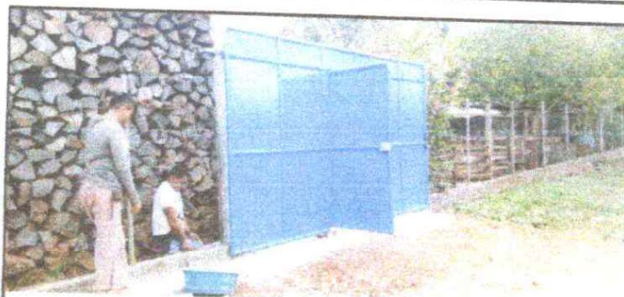
FOTO 4: DESARROLLO DE LA INSTALACIÓN DEL PORTON CORREDIZO.
