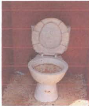
FOTO 7: SUSTITUCIÓN DE SANITARIOS
