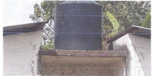
FOTO 8: SUSTITUCIÓN DE DEPÓSITO DE AGUA
