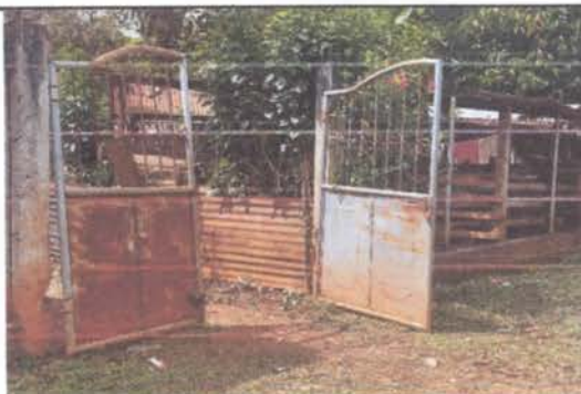
FOTO 4: SUSTITUCION DE PORTON DE METAL
