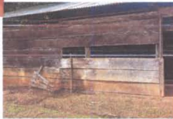
FOTO 9: SUSTITUCIÓN DE PILA DE CEMENTO DE DOS LAVADEROS
