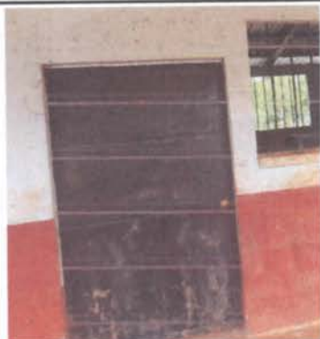
FOTO 3: SUSTITUCION DE CHAPA
