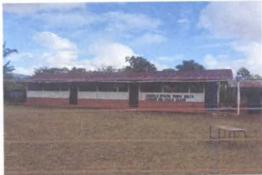
FOTO 1: SUSTITUCIÓN DE LÁMINA
