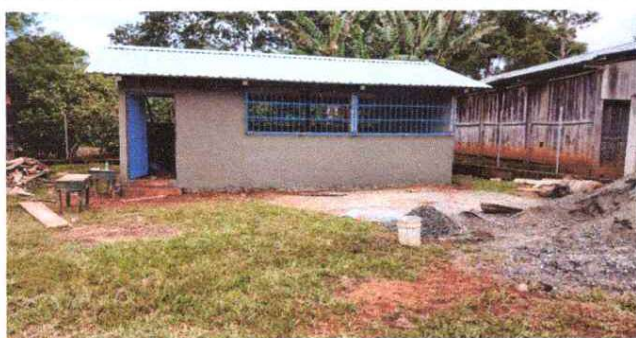
FOTO 6: SE OBSERVA LA FINALIZACIÓN DE LA INSTALACIÓN DE LAMINA TROQUELADA
