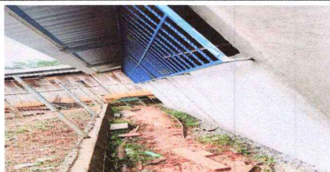
FOTO 7: SE OBSERVA LA FINALIZACIÓN DE LA INSTALACIÓN DE BALCONES
