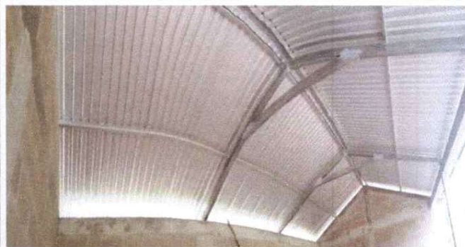
FOTO 5: SE OBSERVA LA FINALIZACIÓN DE LA INSTALACIÓN DE ESTRUCTURAS METÁLICAS
