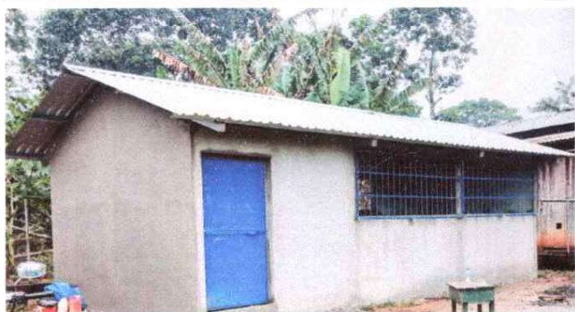
FOTO 4: SE OBSERVA LA FINALIZACIÓN DEL LEVANTAMIENTO DE MURO
