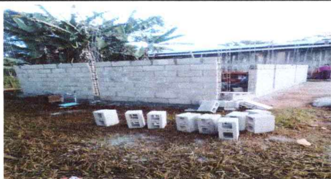
FOTO 4: SE OBSERVA EL PROCESO DEL LEVANTAMIENTO DE MURO
