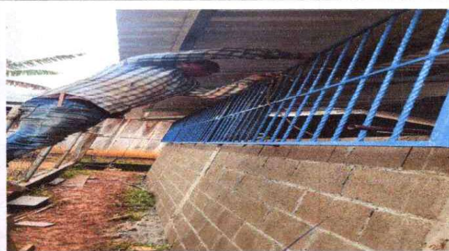
FOTO 7: SE OBSERVA LA FABRICACIÓN E INSTALACIÓN DE BALCONES
