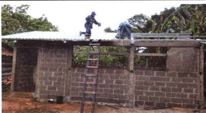
FOTO 6 : SE OBSERVA LA INSTALACIÓN DE LAMINA TROQUELADA.
