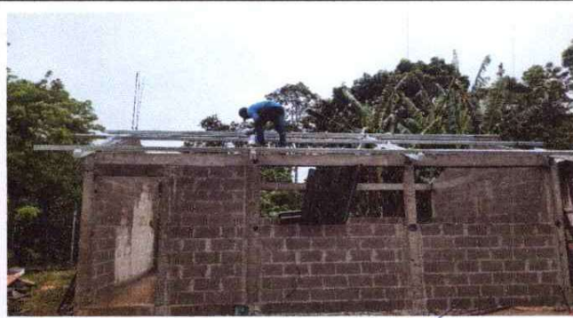
FOTO 5: SE OBSERVA EL PROCESO DE LA INSTALACION DE ESTRUCTURAS METALICAS
