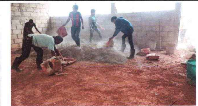
FOTO 9: SE OBSERVA LA SUSTITUCIÓN DE PISO DE TORTA
