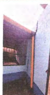
Foto 6: SUSTITUCIÓN DE BAJADA DE AGUA PLUVIAL DE METAL POR TUBO PVC 3"
