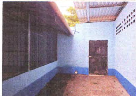
Foto7: PINTURA EN MUROS EXTERIORES E INTERIORES
