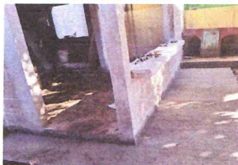
Foto 8: REPARACIÓN DE TAPADERAS DE CAJAS
