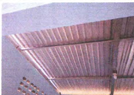
Foto1: SUSTITUCIÓN DE LÁMINAS, POR LÁMINAS TROQUELADA ALUZINC CALIBRE 26
