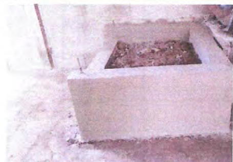
Foto 9: REPARACION DE ESTUFA RURAL
