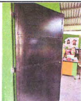
Foto 3: SUSTITUCIÓN DE PUERTAS
