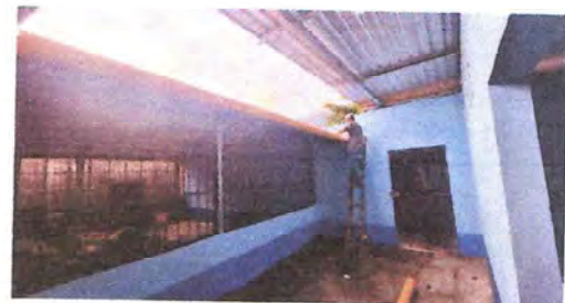
Foto 6: SUSTITUCIÓN DE BAJADA DE AGUA PLUVIAL DE METAL POR TUBO PVC 3"
