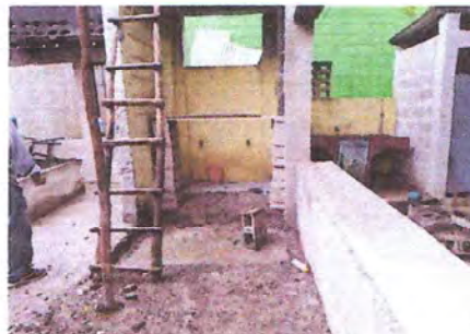
Foto 8: REPARACIÓN DE TAPADERAS DE CAJAS
