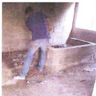
Foto 9: REPARACION DE ESTUFA RURAL
