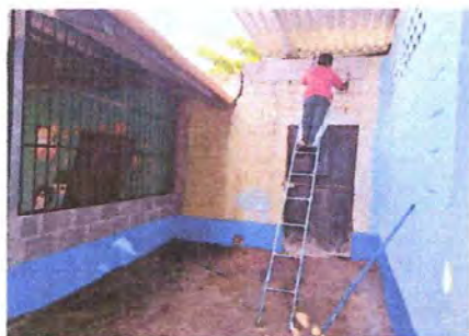
Foto7: PINTURA EN MUROS EXTERIORES E INTERIORES
