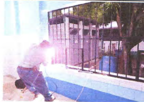
Foto 4: SUSTITUCIÓN DE BALCONES DE METAL
