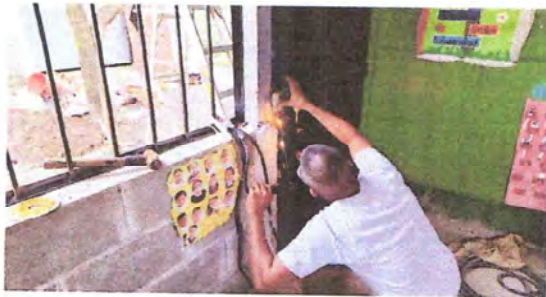
Foto 3: SUSTITUCIÓN DE PUERTAS
