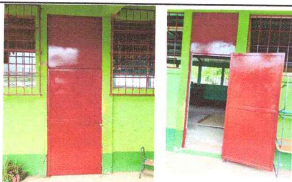
FOTO 3: FINALIZACIÓN DE MANTENIMIENTO A PUERTAS DE METAL
