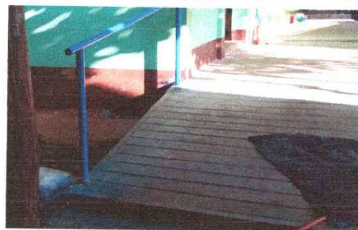
FOTO 6: FINALIZACIÓN DE REALIZACIÓN DE RAMPA DE CONCRETO
