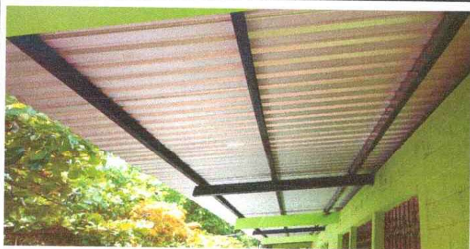
FOTO 1: FINALIZACIÓN DE SUSTITUCION DE LAMINA POR LAMINA TROQUEALDA
