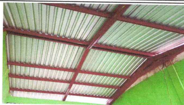
FOTO 2: FINALIZACIÓN DE CAMBIO DE LAMINA POR LAMINA TROQUELADA
