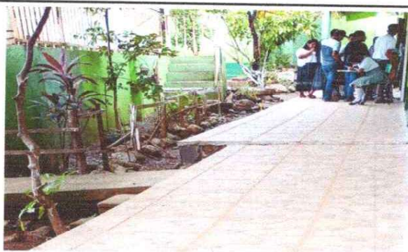
FOTO 4: FINALIZACIÓN DE REPARACION DE PISO TORTA POR PISO CERAMICO ANTIDESLIZANTE
