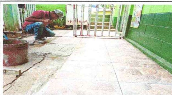
FOTO 4: REPARACION DE PISO TORTA POR PISO CERAMICO ANTIDESLIZANTE
