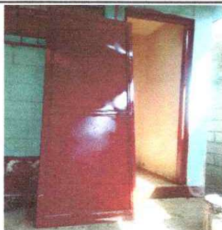
FOTO 3: MANTENIMIENTO A PUERTAS DE METAL
