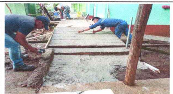
FOTO 6: REALIZACIÓN DE RAMPA DE CONCRETO
