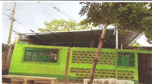
FOTO 1: PROCESO DE SUSTITUCION DE LAMINA POR LAMINA TROQUELADA
