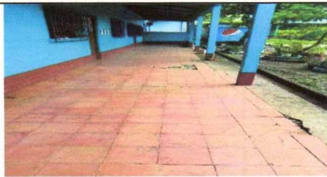
FOTO 5: REPARACION DE PISO TORTA
