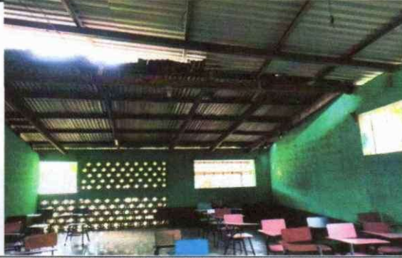
FOTO 1: SUSTITUCION DE LAMINA POR LAMINA TROQUEALDA
