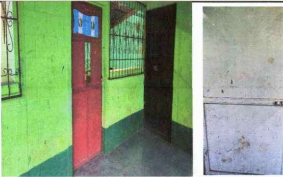
FOTO 3: MANTENIMIENTO A PUERTAS DE METAL
