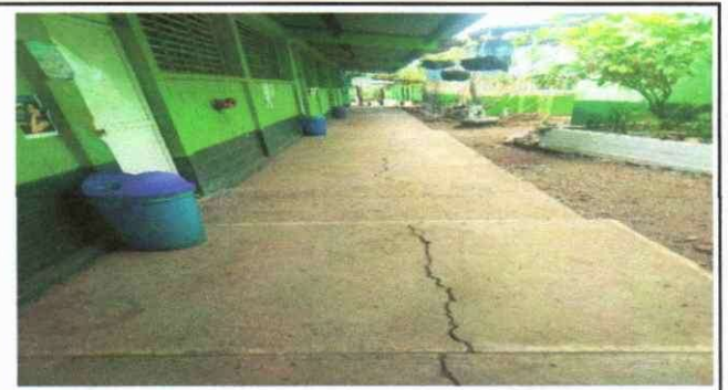
FOTO 4: REPARACION DE PISO TORTA
