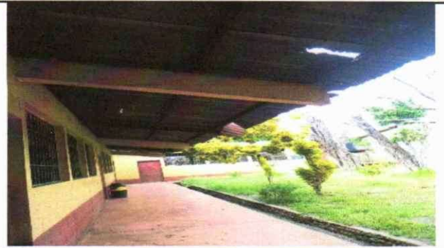
FOTO 2: SUSTITUCION DE LAMINA POR LAMINA TROQUELADA
