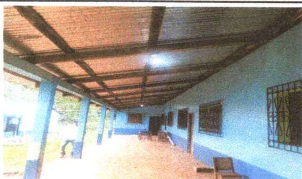
Foto 3: SUSTITUCIÓN DE SISTEMA ELÉCTRICO
