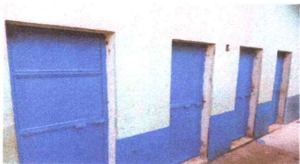
FOTO 1: SUSTITUCIÓN DE PUERTAS DE SANITARIOS
