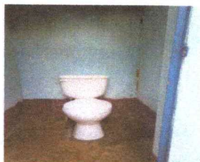
FOTO 6: SUSTITUCIÓN DE INODOROS
