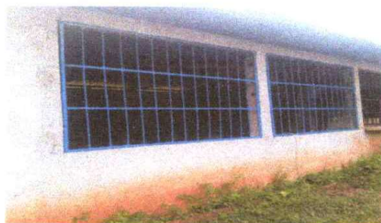
FOTO 5: SUSTITUCIÓN BARANDA POR METAL
