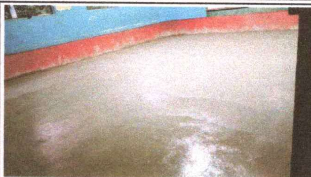
FOTO 2: SUSTITUCIÓN DE PISO DE CONCRETO
