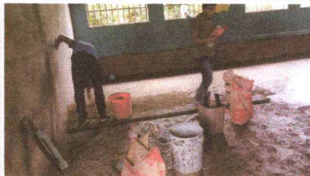
FOTO 2: SUSTITUCIÓN DE PISO DE CONCRETO
