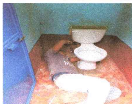
FOTO 6: SUSTITUCIÓN DE INODOROS
