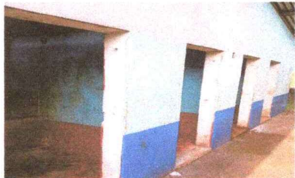
FOTO 1: SUSTITUCIÓN DE PUERTAS DE SANITARIOS
