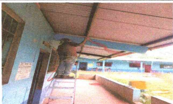
Foto 3: SUSTITUCIÓN DE SISTEMA ELÉCTRICO
