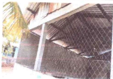
FOTO 5: Sustitución baranda por metal
