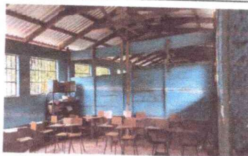
FOTO 4: Reparación y mantenimiento de paredes
