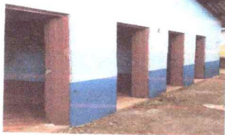
FOTO 1: Sustitución de puertas de servicios sanitarios
