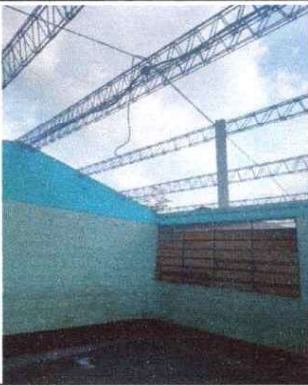
FOTO 3: MANTEMIENTO A ESTRUCTURA DE METAL
