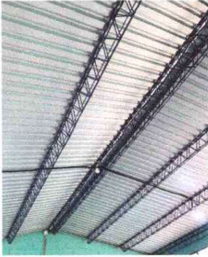
FOTO 1: SUSTITUCION DE LAMINA POR LAMINA TROQUELADA
