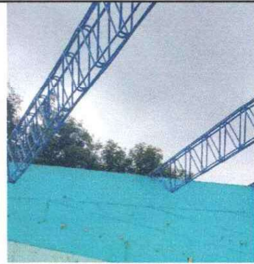
FOTO 4: MANTENIMIENTO A ESTRUCTURA DE METAL
