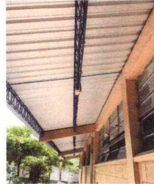
FOTO 2: SUSTITUCION DE LAMINA POR LAMINA TROQUELADA
