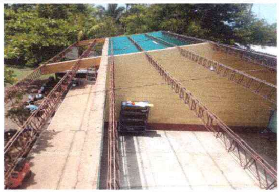
FOTO 2: DESMONTAJE DE LAMINA
