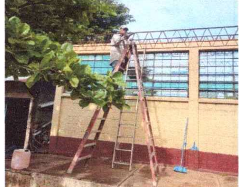
FOTO 4: MANTENIMIENTO A ESTRUCTURA DE METAL
