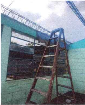
FOTO 3: MANTENIMIENTO A ESTRUCTURA DE METAL
