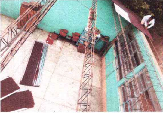
FOTO 1: DESMONTAJE DE LAMINA
