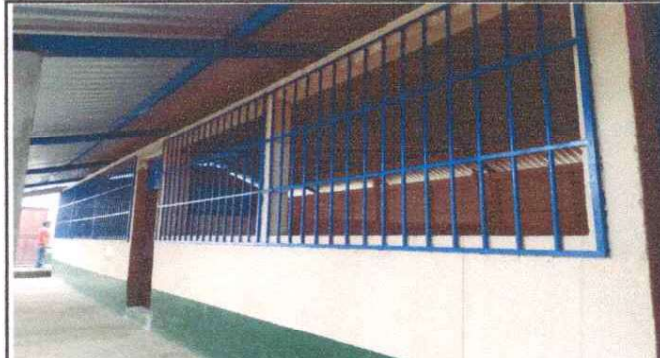
MANTENIMIENTO A BALCONES DE METAL
