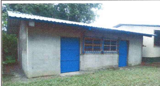
SUSTITUCIÓN DE LÁMINA POR LÁMINA TROQUELADA ALUZINC CALIBRE 26 Y ESTRUCTURA DE MADERA POR METAL DE BODEGA.
