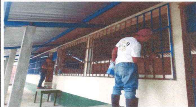
MANTENIMIENTO A BALCONES DE METAL
