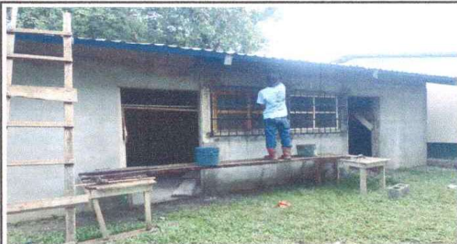
REPELLO EN MURO DE BODEGA.
