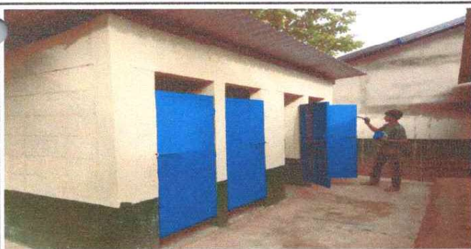
MANTENIMIENTO A ESTRUCTURA LIJADO Y APLICACIÓN DE PINTURA A PUERTAS DE SERVICIOS SANITARIOS.
