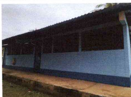
FOTO 8: PINTURA EN MUROS INTERIOR Y EXTERIOR
