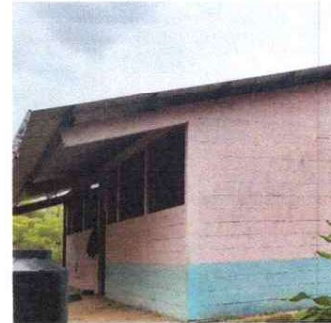
FOTO 2: SUSTITUCION DE LAMINA POR LAMINA TROQUELADA
