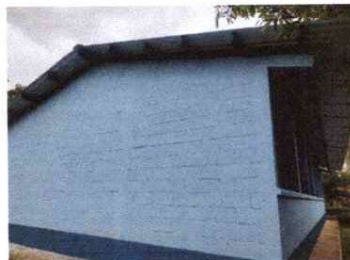
FOTO 10: PINTURA EN MUROS INTERIOR Y EXTERIOR
