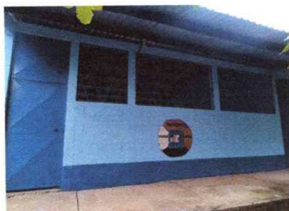
FOTO 9: PINTURA EN MUROS INTERIOR Y EXTERIOR
