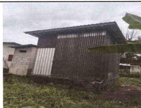
FOTO 3: SUSTITUCION DE LAMINA POR LAMINA TROQUELADA
