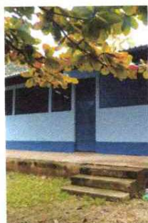
FOTO 11: MANTENIMIENTO DE PUERTAS DE METAL
