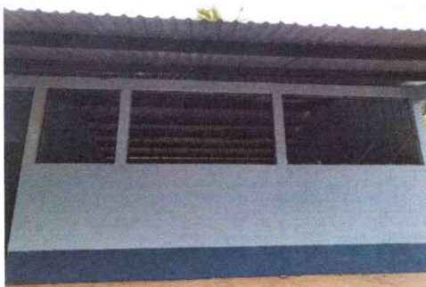
FOTO 5: MANTENIMIENTO ESTRUCTURA DE METAL
