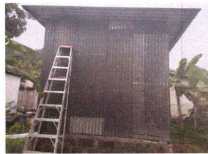
FOTO 4: SUSTITUCION DE LAMINA POR LAMINA TROQUELADA
