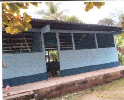
FOTO 7: PINTURA EN MUROS INTERIOR Y EXTERIOR
