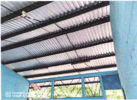
FOTO 1: SUSTITUCION DE LAMINA POR LAMINA TROQUELADA
