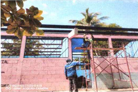
FOTO 1: SUSTITUCION DE LAMINA POR LAMINA TROQUELADA
