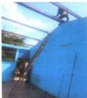
FOTO 5: MANTENIMIENTO A ESTRUCTURA DE DE SOPORTE DE METAL
