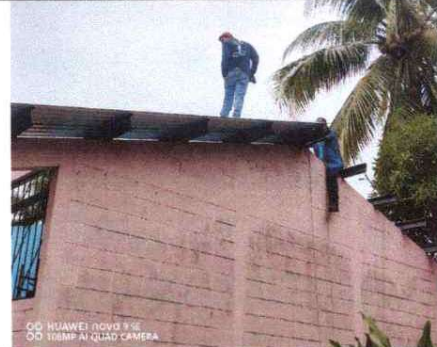
FOTO 2: SUSTITUCION DE LAMINA POR LAMINA TROQUELADA
