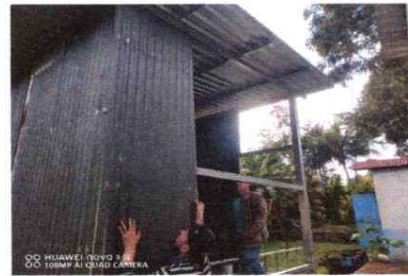
FOTO 4: SUSTITUCION DE LAMINA POR LAMINA TROQUELADA
