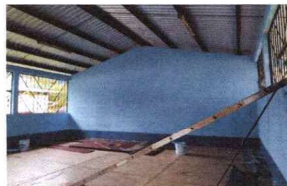
FOTO 10: PINTURA EN MURO INTERIOR Y EXTERIOR
