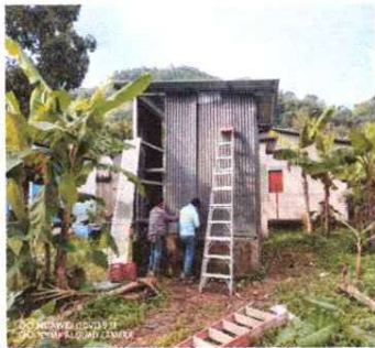
FOTO 3: SUSTITUCION DE LAMINA POR LAMINA TROQUELADA
