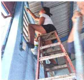
FOTO 9: PINTURA EN MURO INTERIOR Y EXTERIOR
