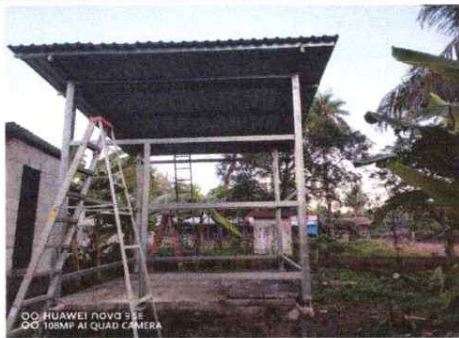
FOTO 7: MANTENIMIENTO A ESTRUCTURA DE DE SOPORTE DE METAL
