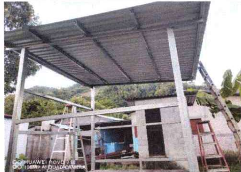
FOTO 8: MANTENIMIENTO A ESTRUCTURA DE DE SOPORTE DE METAL
