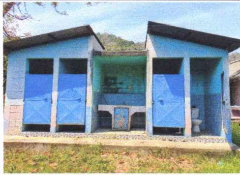
FOTO 4: MANTENIMIENTO DE PUERTAS DE METAL
