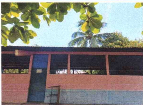
FOTO 3: PINTURA MURO INTERIOR Y EXTERIOR
