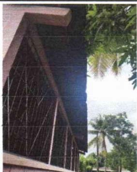
FOTO 1: SUSTITUCION DE LAMINA POR LAMINA TROQUEALDA
