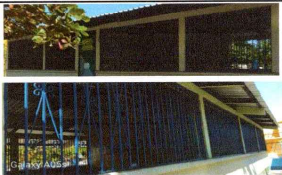
Foto 2: Sustrucción de estructura de madera por metal de ventana
