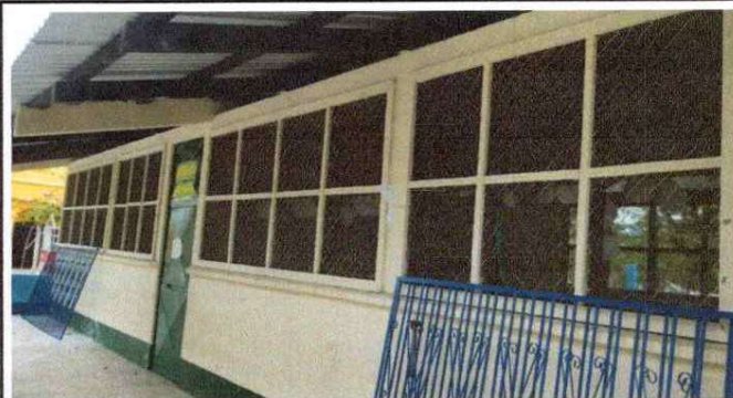
Foto 2: Sustitución de estructura de madera por metal de ventana
