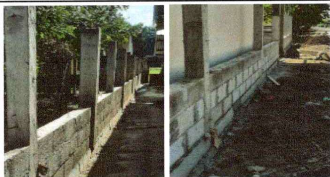
Foto 3: Reparación de muro perimetral de block con tubo hg y malla galvanizada
