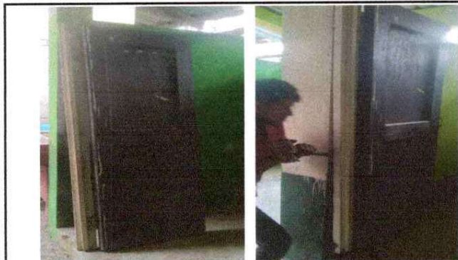
Foto1: Sustitución de puerta, aulas y sanitarios
