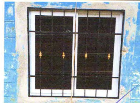
Foto 6: SUSTITUCION VENTANAS DE MADERA POR METAL Y VIDRIO
