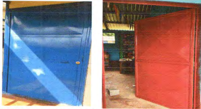
Foto1: SUSTITUCION DE CHAPAS Y PINTADA DE PUERTAS
