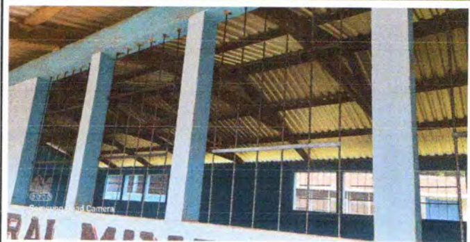
Foto 4: MANTENIMIENTO DE BALCONES DE METAL
