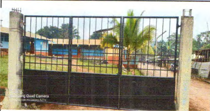
Foto 3: SUSTITUCION DE PORTON DE METAL
