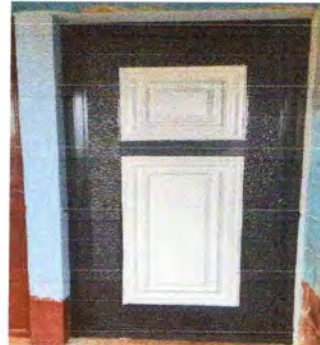
Foto 2: SUSTITUCION DE PUERTAS
