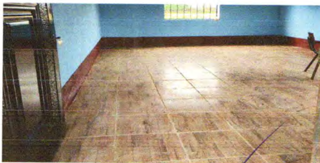
Foto 5: REPARACION DE PISO CERRAMICA
