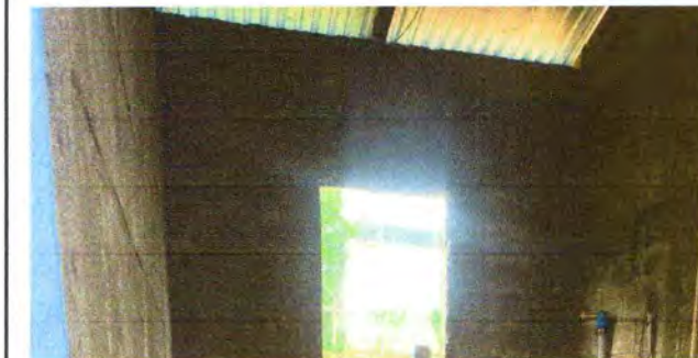
Foto 2: REMODELACION DE CIELO FALSO EN LA DIRECCION
