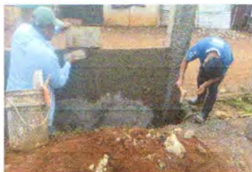
Foto1: SUSTITUCION DE MURO PERIMETRAL DE BLOCK CON BARANDAS DE METAL
