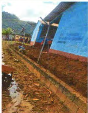
Foto1: SUSTITUCION DE MURO PERIMETRAL DE BLOCK CON BARANDAS DE METAL
