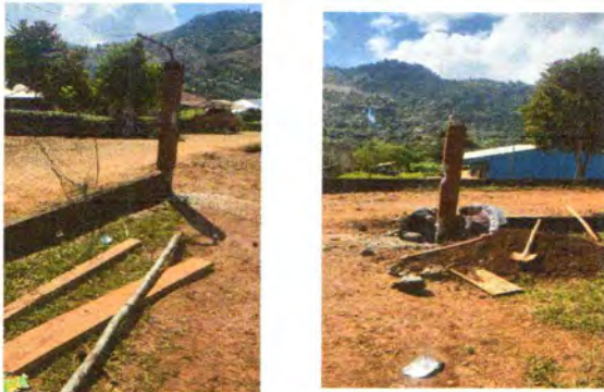
Foto 3: SUSTITUCION DE PORTON DE METAL
