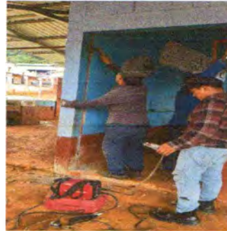
Foto 2: SUSTITUCION DE PUERTAS
