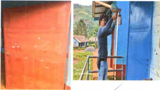
Foto 1: SUSTITUCION DE CHAPAS Y PINTADA DE PUERTAS
