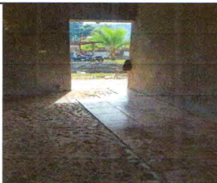
Foto 5: REPARACION DE PISO CERRAMICA
