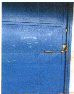
Foto 1 sustitucion de chapas
