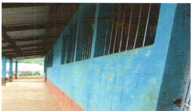
Foto 5. Susutitucion de balcones de metal
