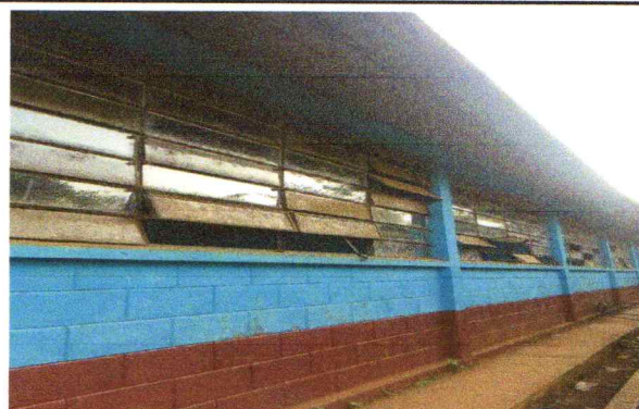
Foto 4. Sustitucion de vidrios
