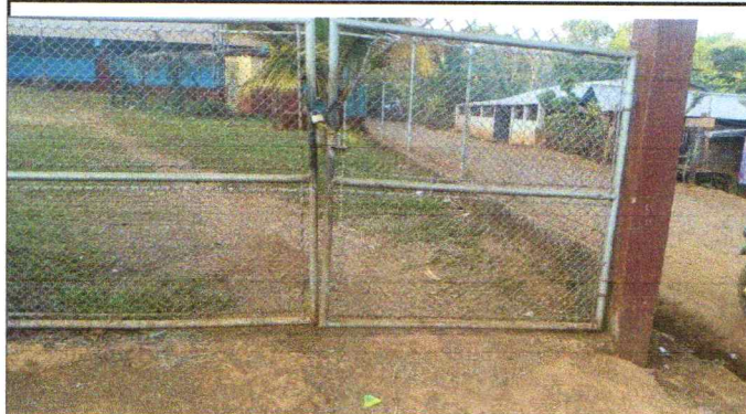
Foto 3. Sustitucion de porton metal
