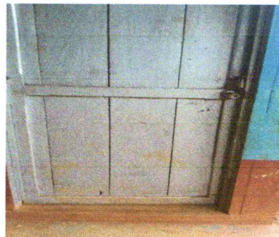
Foto 2. Sustitucion de puertas
