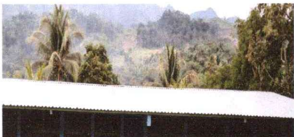
Foto1: SUSTITUCION DE LÁMINAS,
