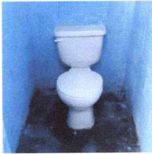
Foto7: SUSTITUCIÓN DE INODOROS
