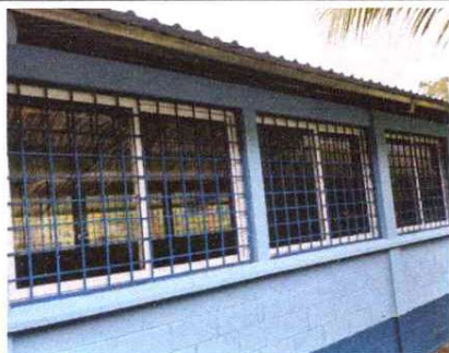
Foto 5: SUSTITUCION DE ESTRUCTURAS DE METAL DE VENTANA Y SUSTITUCION DE VIDRIOS.
