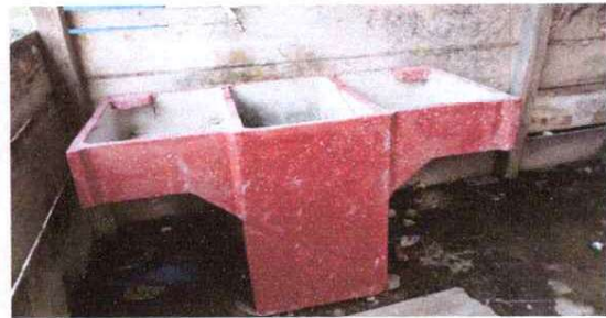
Foto.8SUSTITUCIÓN DE PILA DE CEMENTO DE DOS LAVADERO
