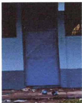
Foto 3: SUSTITUCION DE PUERTAS DE METAL.
