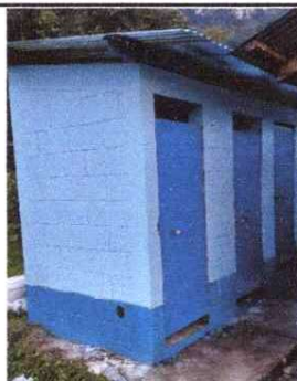
Foto 4: SUSTITUCIÓN DE PUERTAS EN SERVICIOS SANITARIOS.
