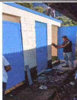
Foto 4: SUSTITUCIÓN DE PUERTAS EN SERVICIOS SANITARIOS.
