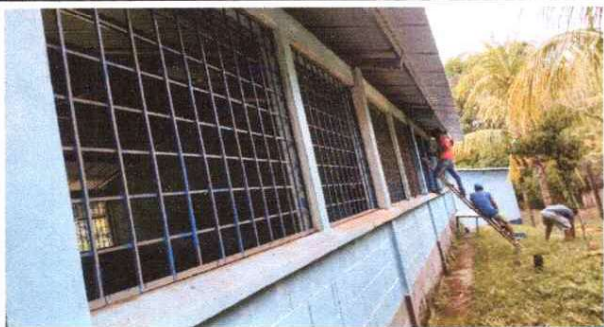
Foto 5: SUSTITUCIÓN DE ESTRUCTURA DE METAL DE VENTANA Y SUS SUSTITUCION.
