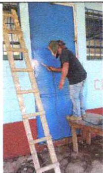
Foto 3: SUSTITUCIÓN DE PUERTAS DE METAL.
