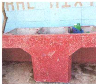
Foto 8: SUSTITUCION DE PILA DE CEMENTO DE DOS LAVADERO
