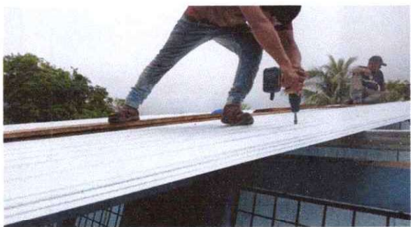
Foto1: SUSTITUCION DE LÁMINA, POR LÁMINA TROQUELADAS ALUZINC CALIBRE 26.
