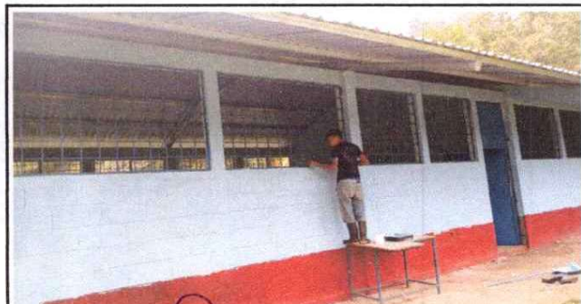
Foto 6: PINTURA EN MUROS EXTERIORES E INTERIORES
