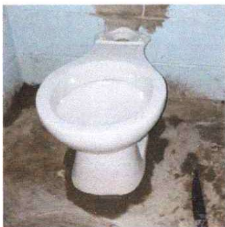
Foto7: SUSTITUCION DE INODORO.
