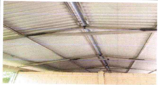
FOTO 2: SUSTITUCION DE SOPORTE DE MADERA POR METAL
