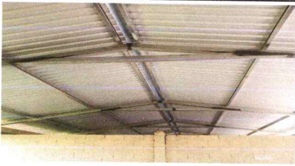
FOTO 1: SUSTITUCION DE LAMINA, POR LAMINA TROQUELADA ALUZIN CALIBRE 26
