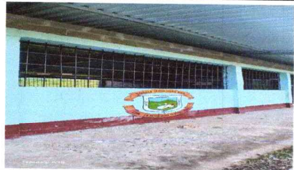
FOTO 4 : BALCONES DE METAL
