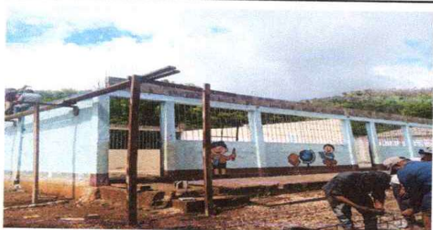
FOTO 5: LEVANTAMIENTO DE TRES HILADAS DE BLOCK Y MOJINETE.
