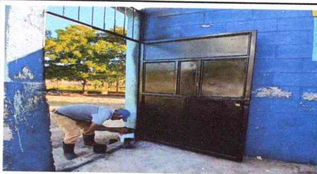
FOTO 3: MATENIMIENTO DE PUERTA DE METAL.
