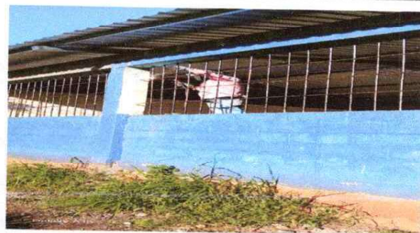
FOTO 4 : MANTENIMIENTO DE BALCONES DE METAL
