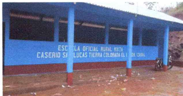
Foto 4: Finalizacion de proyecto.
