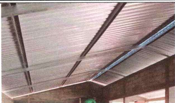
Foto1: Instalacion de estructura metalica y lamina troquelada
