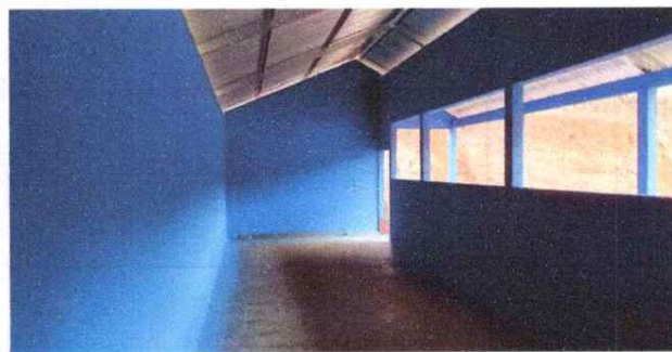
Foto 2: Sustitucion torta de piso de concreto
