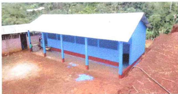
Foto 3: Culminacion de entechado
