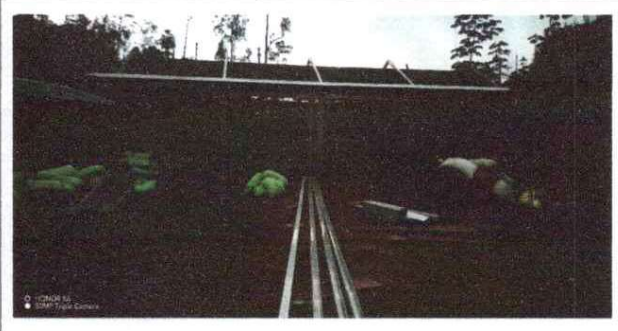
Foto 2: Colocación de estructura metálica
