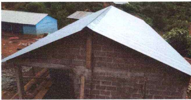
Foto 3: Instalación de lámina por lámina troquelada
