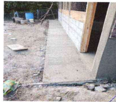
FOTO 4: REPARACION DE PISO TORTA
