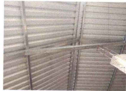
FOTO 2: SUSTITUCION DE ESTRUCTURA DE MADERA POR METAL
