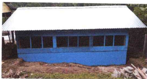
FOTO 7: PINTURA PAREDES EXTERIORES
