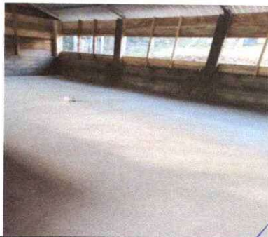
FOTO 3: REPARACION DE PISO TORTA
