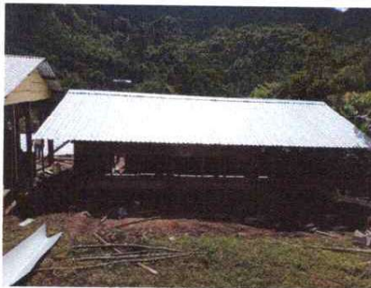
FOTO 1: SUSTITUCION DE LAMINA POR LAMINA TROQUELADA
