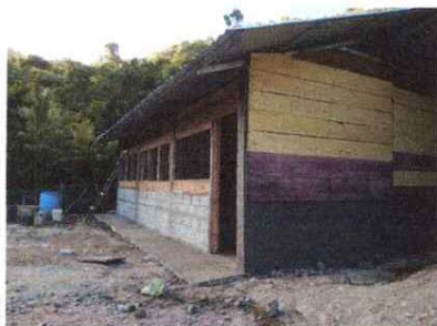
Foto 5: LEVANTADO DE MURO
