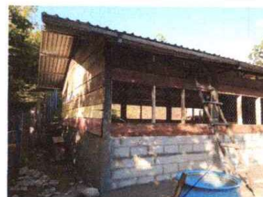
Foto 6: LEVANTADO DE MURO
