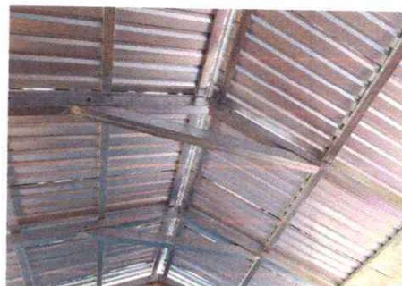
FOTO 4: INSTALACION DE LAMINA TROQUELADA CAL. 28
