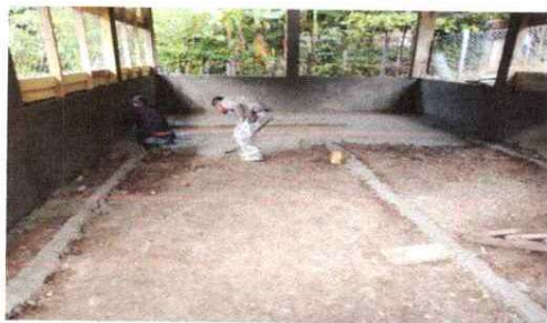
Foto 5: INSTALACION DE PISO TORTA
