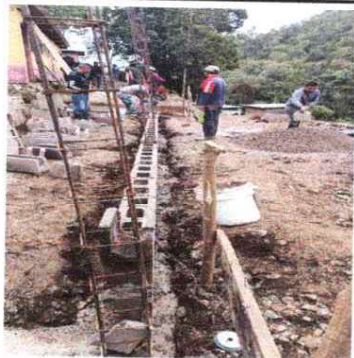
FOTO 1: LEVANTADO DE PAREDES
