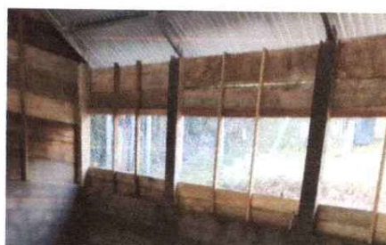
Foto 6: INSTALACION DE MADERA Y MALLA EN PARED
