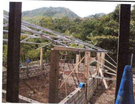
FOTO 2: INSTALACION DE ESTRUCTURA DE METAL PARA TECHO
