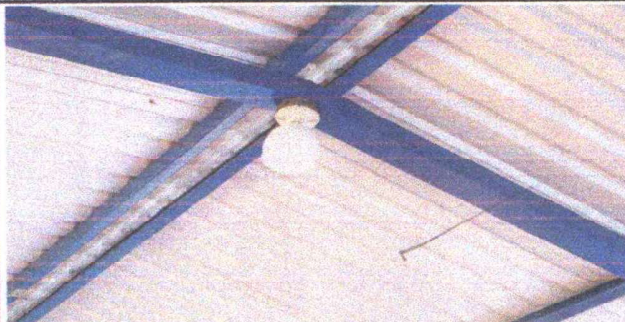
Foto 6: REPARACIÓN DE SISTEMA ELÉCTRICO.
