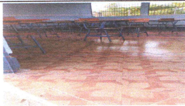
Foto 4: SUSTITUCIÓN DE PISO CERÁMICO.
