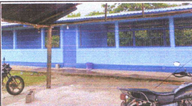
Foto 5: PINTURA EN MUROS EXTERIORES.
