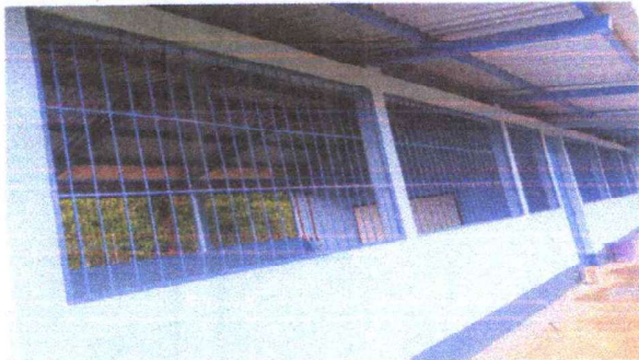
Foto 3: MANTENIMIENTO DE BALCONES DE METAL.
