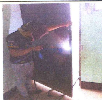
Foto 2: SUSTITUCIÓN DE PUERTA Y CHAPA
