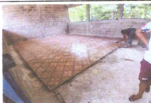
Foto 4: SUSTITUCIÓN DE PISO CERÁMICO.
