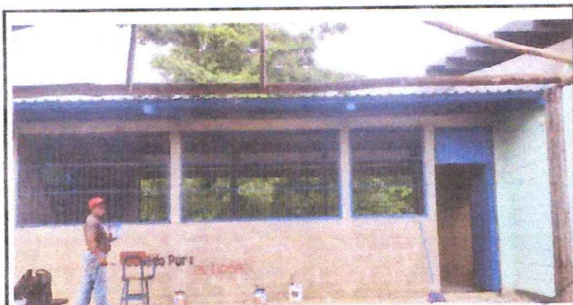
Foto 3: MATENIMIENTO DE BALCONES DE METAL.
