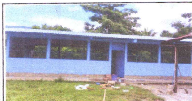
Foto 5: PINTURA EN MUROS EXTERIORES.
