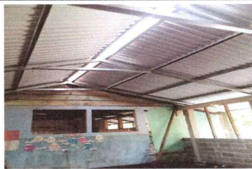
FOTO 4: INSTALACIÓN DE LAMINA TROQUELADA
