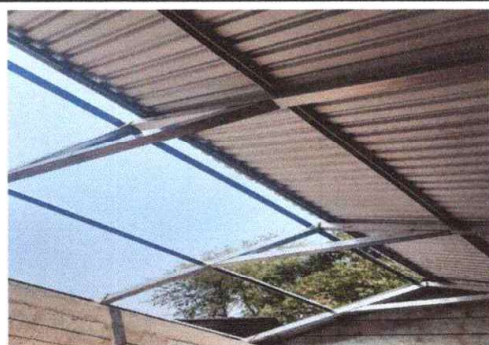
FOTO 3: INSTALACIÓN DE LAMINA TROQUELADA
