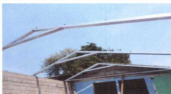
Foto1: SUMINISTRO E INSTALACIÓN DE ESTRUCTURA METALICA
