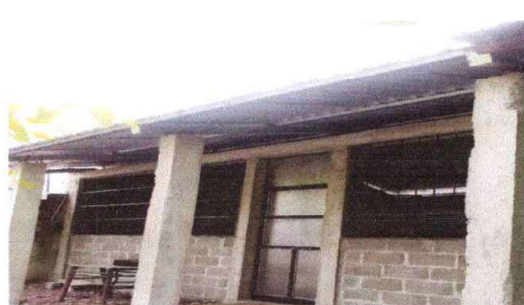
Foto 6: FABRICACIÓN E INSTALACION DE PUERTA
