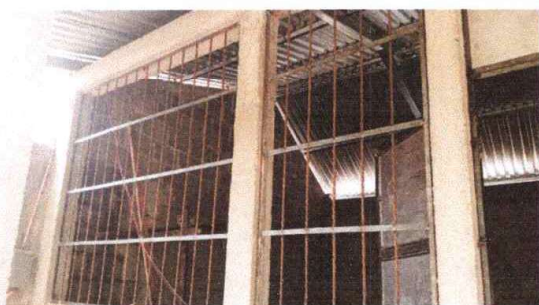
Foto 5: FABRICACIÓN E INSTALACION DE BALCONES
