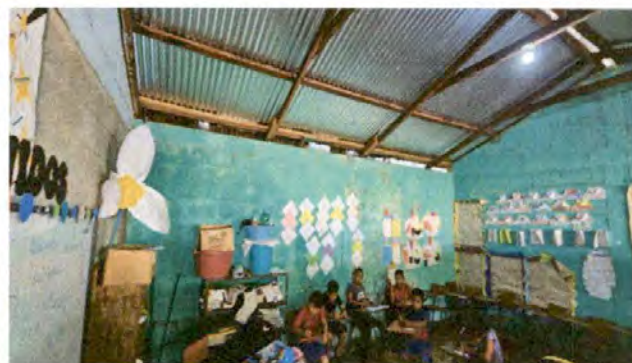
Foto 10: SUMINISTRO E INSTALACION DE ESTRUCTURA METALICA
