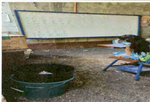
Foto 9: SUMINISTRO E INSTALACION DE PISO CERAMICO ANTIDESLIZANTE.
