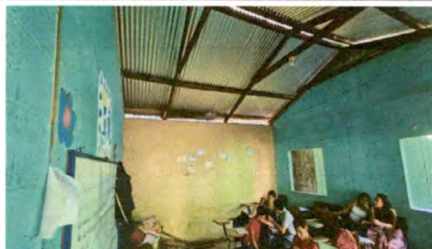
Foto 11: SUMINISTRO E INSTALACION DE ESTRUCTURA METALICA
