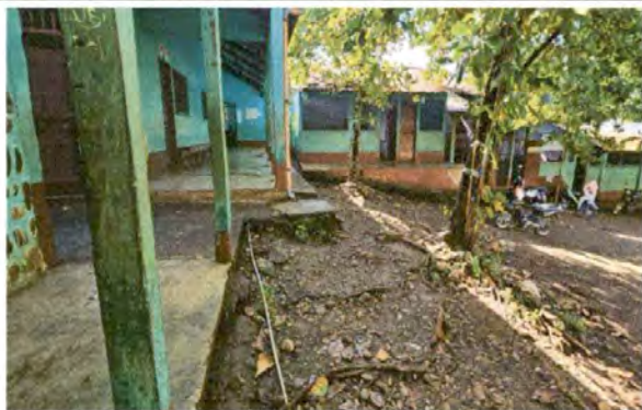
Foto 3: REPARACION DE BANQUETA DE CONCRETO
