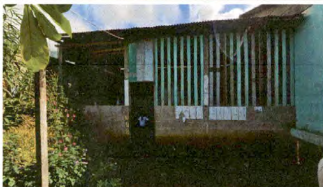
Foto7: . REMOZAMIENTO DE AULA
