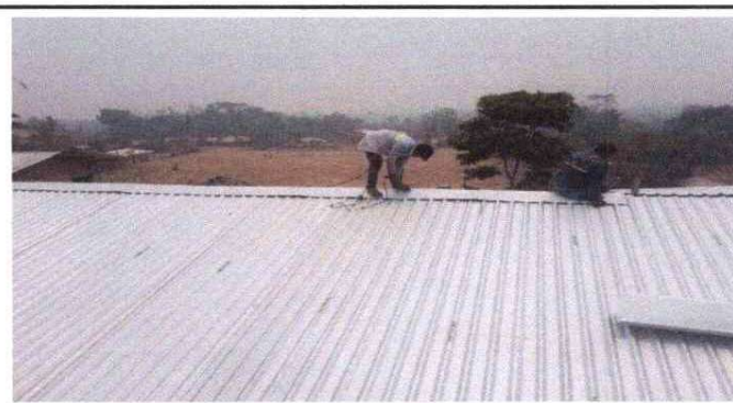
6. INSTALACIÓN DE LAMINAS TROQUELADAS.
