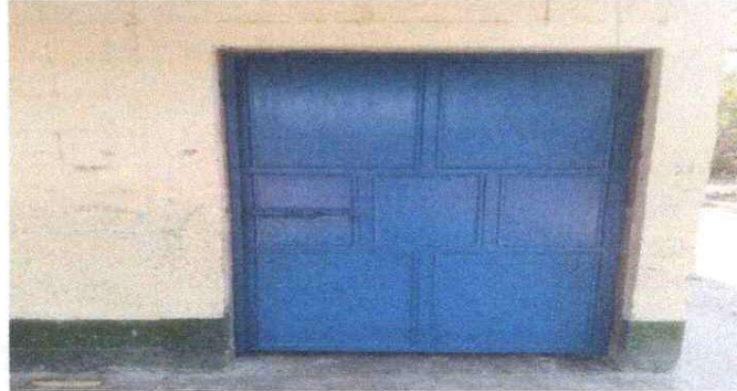
2. FABRICACIÓN E INSTALACIÓN DE PUERTAS.
