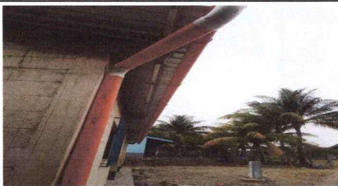
4. INSTALACIÓN DE CANALES.
