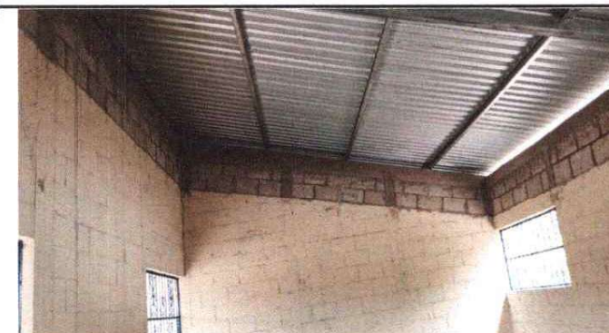
5. FABRICACIÓN E INSTALACIÓN DE ESTRUCTURA METALICA.
