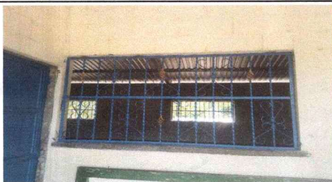
3. FABRICACIÓN E INSTALACIÓN DE 7 BALCONES.
