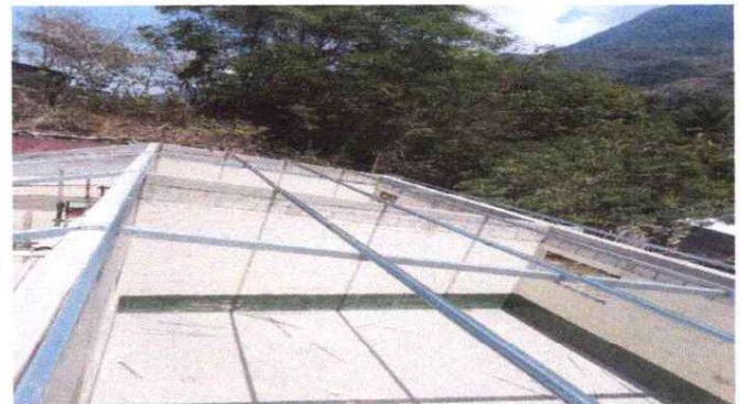
4. FABRICACIÓN E INSTALACION DE ESTRUCTURA METALICA.
