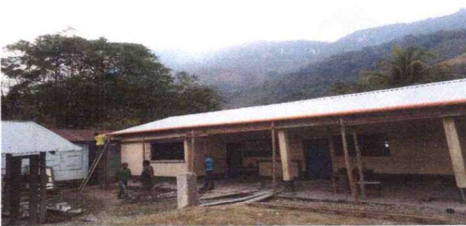
3. INSTALACIÓN DE CANALES.
