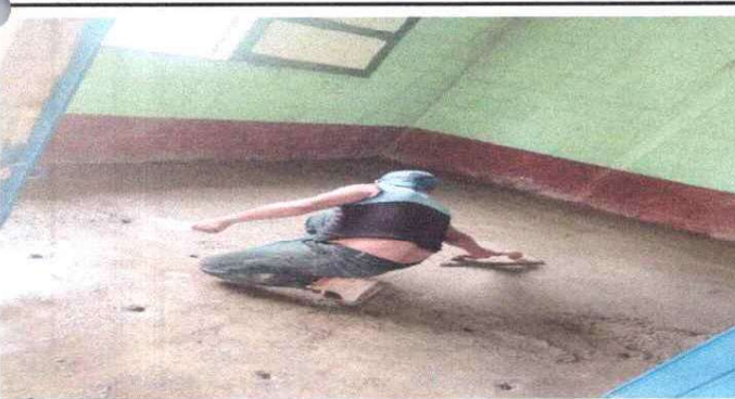
5. REMODELACIÓN PISO DE TORTA A LISO.
